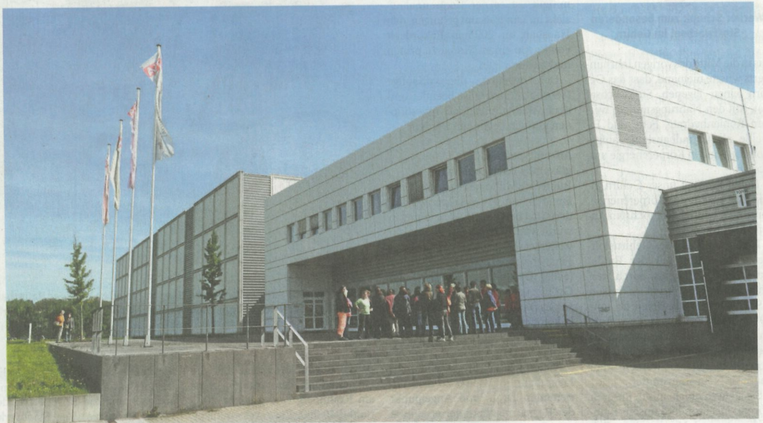
Das Gebäude im Luftschiffhafen, in das aktuell Twenty 5 Logistik eingemietet ist, stammt aus den 1990er-Jahren und beherbergte anfangs die Verlagsauslieferung Langenscheidt, später ab 2010 das Unternehmen Rhenus.
