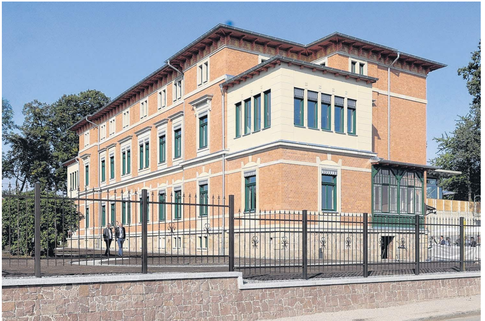
Die Villa Schön in Pölbitz erstrahlt in neuem alten Glanz. Metawerk hat sie restaurieren lassen und wird sie künftig als Firmensitz nutzen.
