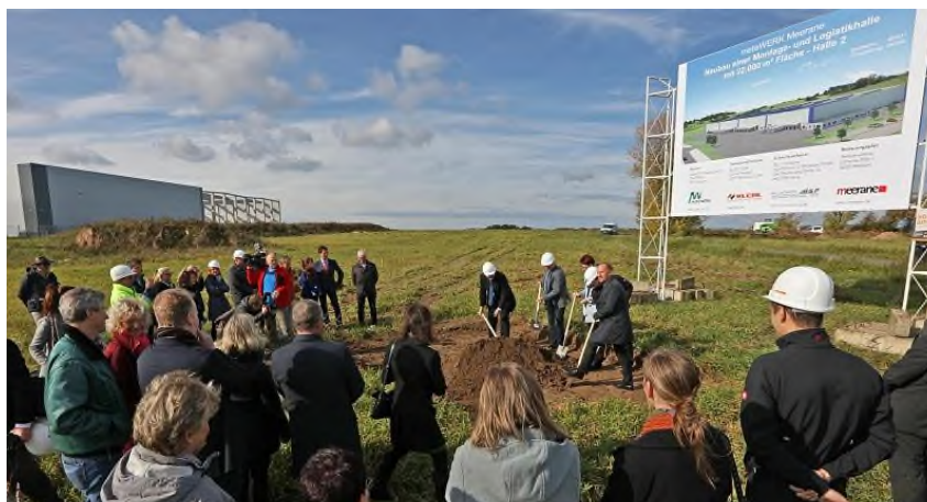
Für den Logistiker Rhenus baut das Metawerk seit Oktober 2017 eine Montagehalle. (c) Ralph Köhler/ Archiv
