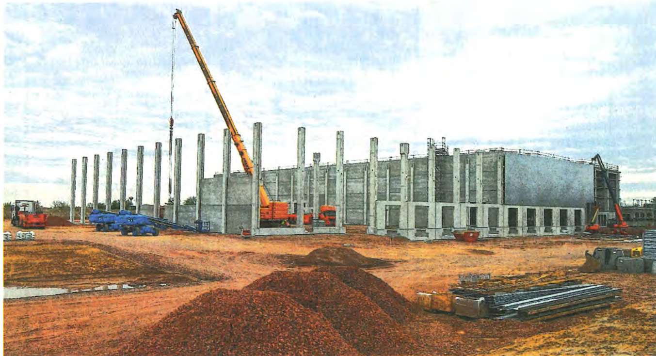
Nach dem Innenausbau der Halle sollen die Außenanlagen und die zweite Industriehalle an der B 93 in Angriff genommen werden.
